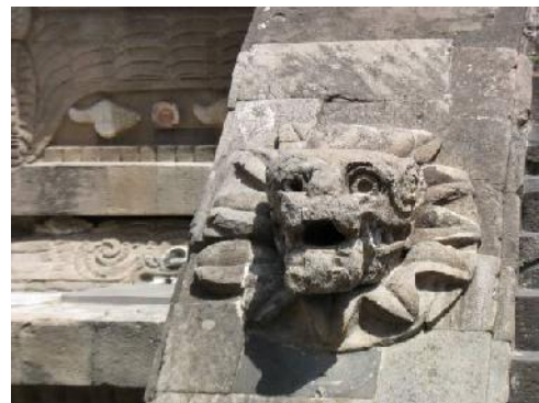
Façade detail, La Ciudadela
